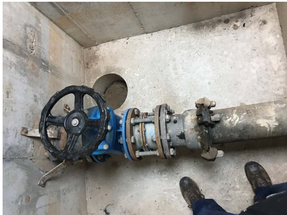
Interior arqueta F6-1V
