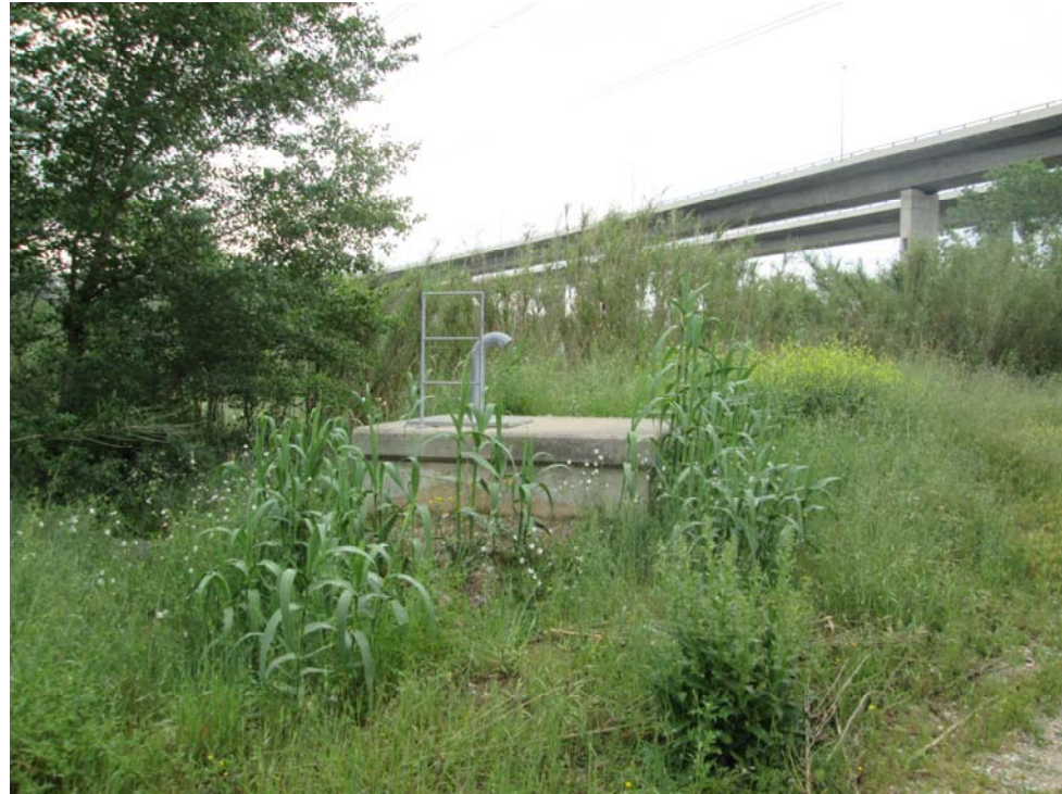
Arqueta F6-1V (Desguàs FD300)
