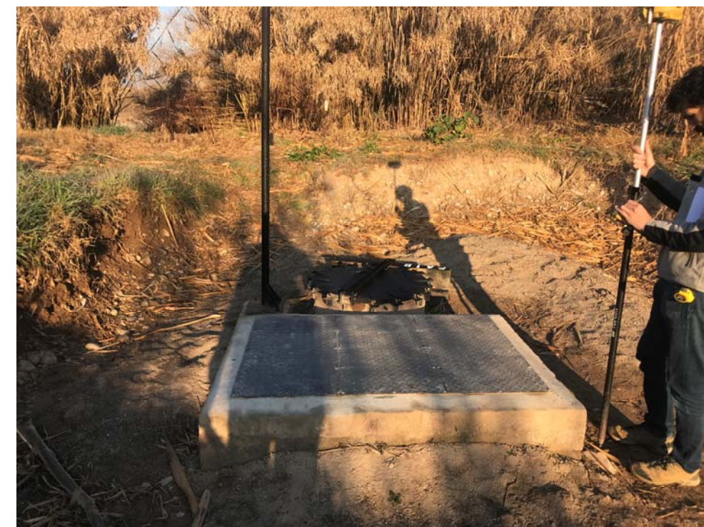
EB pou Mina Pública Terrassa
