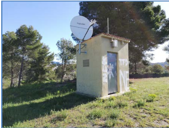
Imatge 1. Exterior de la caseta de comunicació on s'ubica el quadre elèctric.
