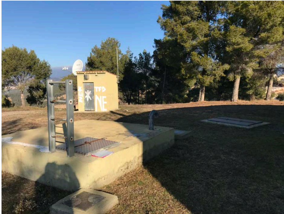
Imatge 2. Imatge de l'exterior del dipòsit de Can Vilalba on es pot observar l'arqueta G6-35 (punt d'arribada de la impulsió) i l'arqueta G6-36 al fons (punt de sortida del dipòsit).
