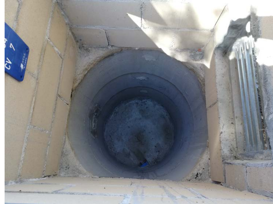
Imatge 8. Imatge de l'interior de l'arqueta de desguàs G6-84.
