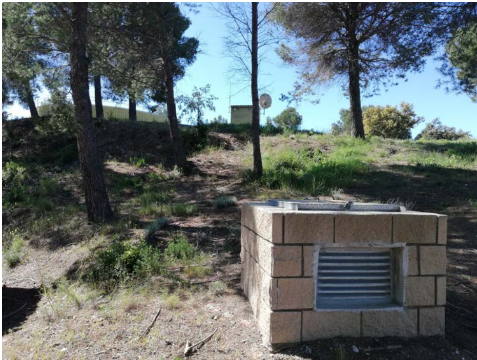
Imatge 7. Imatge de l'exterior de l'arqueta de desguàs G6-84.
