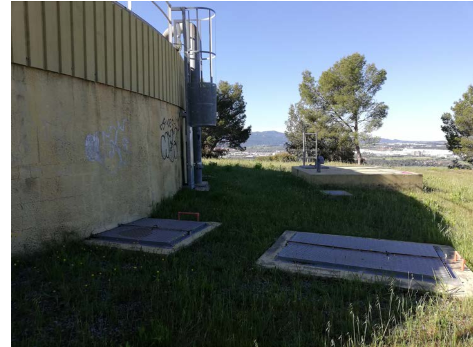
Imatge 4. Imatges de l'exterior de les arquetes de sortida del dipòsit existent (G6-85 i G6-36).
