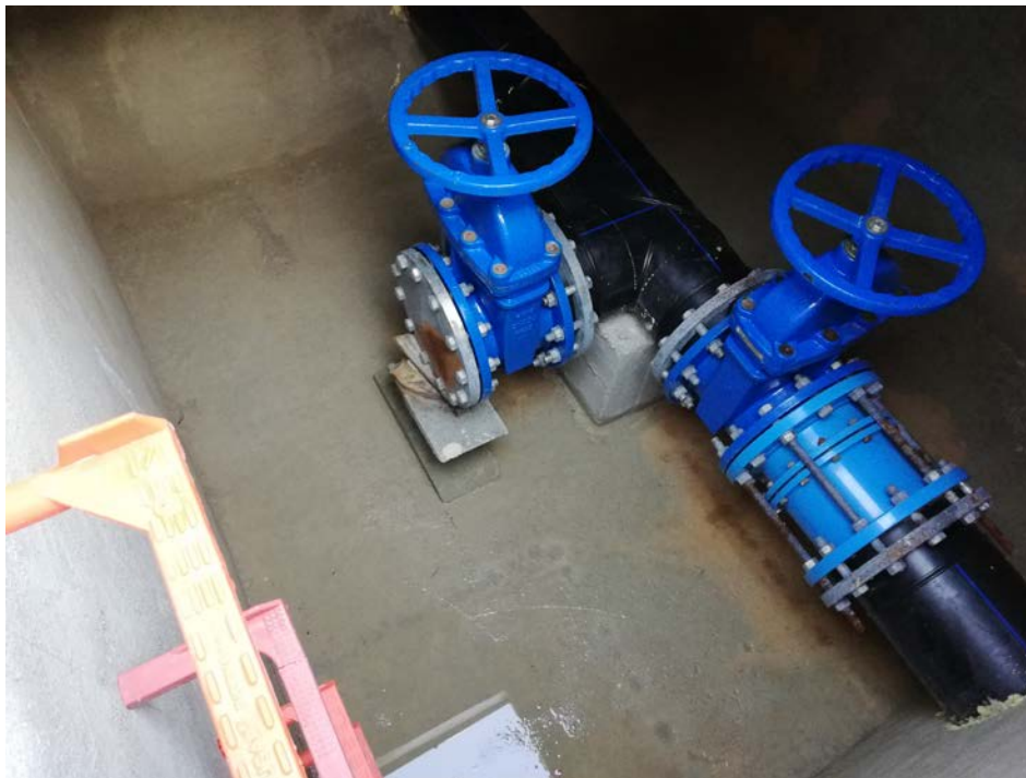
Imatge 3. Imatge de l'interior de l'arqueta G6-35 amb les vàlvules de comporta existents i la derivació preparada pel nou by-pass.
