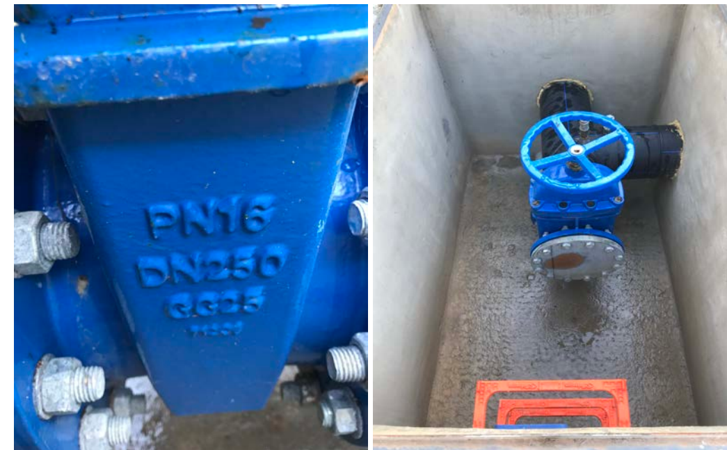
Imatges 5. Imatges de l'interior de l'arqueta G6-36, punt d'arribada del by-pass i detall de la derivació.
