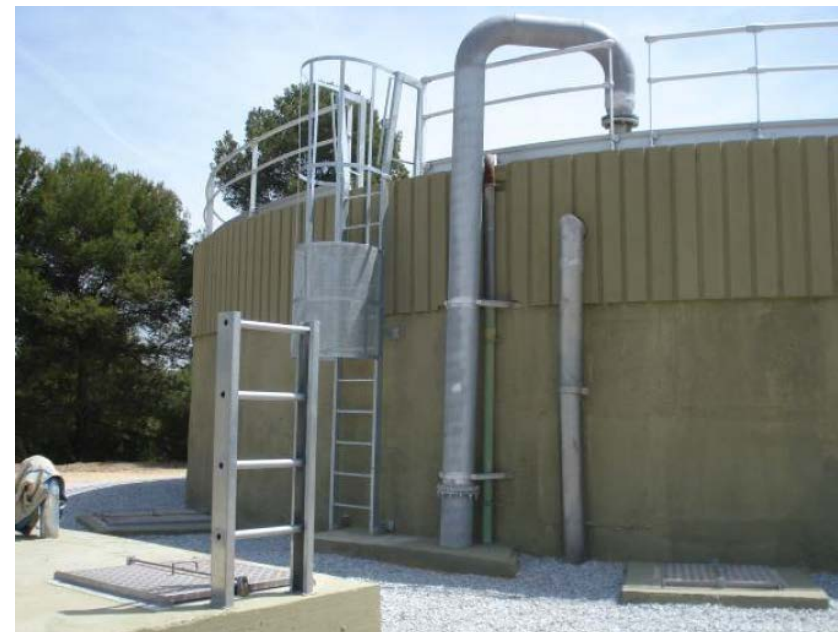
Imatges 1. Imatges de l'exterior del dipòsit de Can Vilalba.
