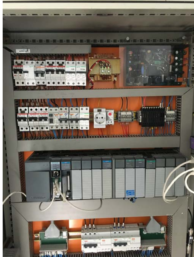
Interior Armari PLC actual
