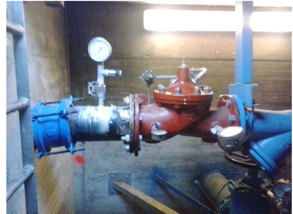
Interior de l'arqueta A1., Vàlvules en la canonada de by-pass
