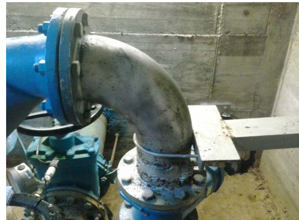
Interior de l'arqueta A1. Detall del colze d'entrada al by-pass
