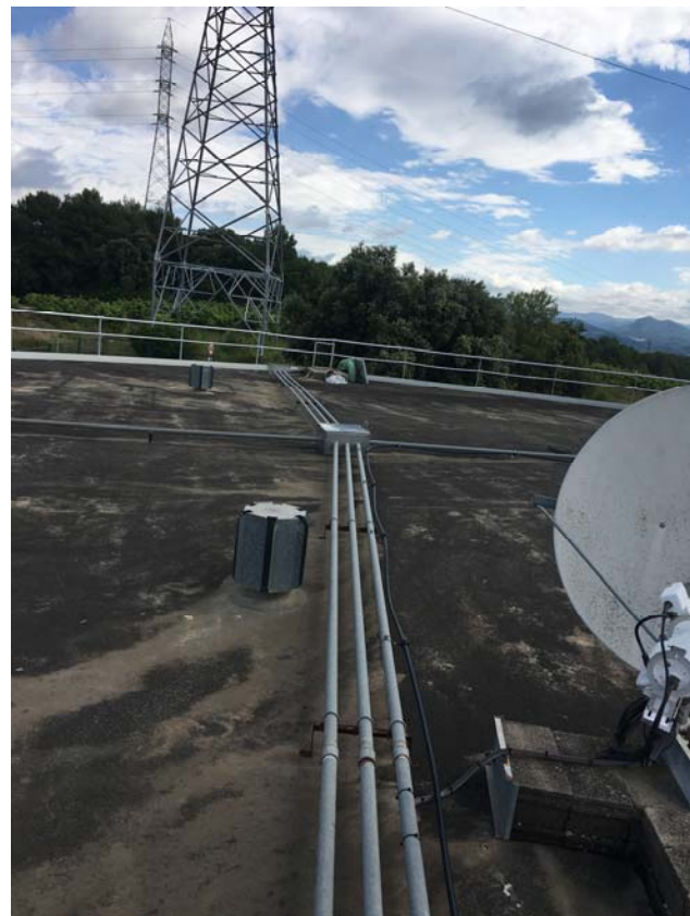
Canalitzacions BT i dades sobre dipòsit i antena de comunicacions per satèl·lit
