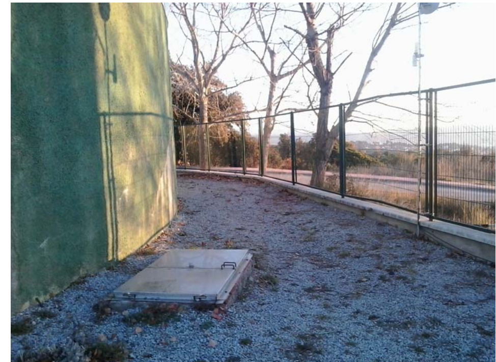
Arqueta A3. Canonada de sortida del dipòsit i canonada de desguàs
