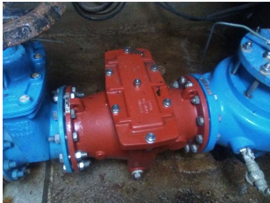
Interior de l'arqueta A1. Filtre a la canonada d'entrada al dipòsit existent
