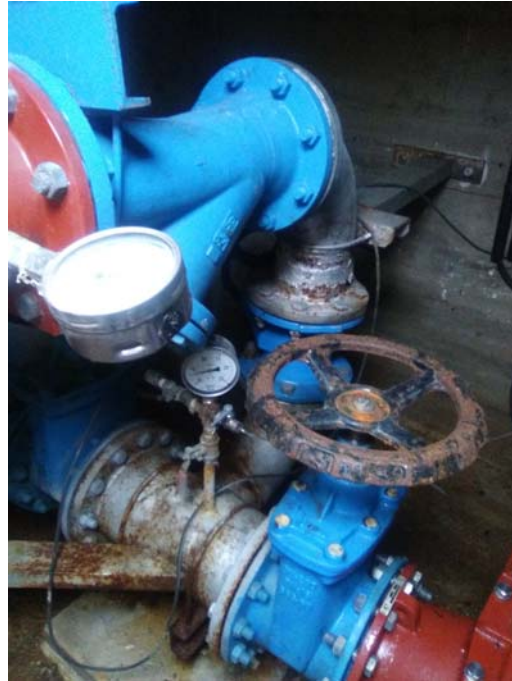
Interior de l'arqueta A1. Vàlvula de comporta a la canonada d'entrada al dipòsit existent
