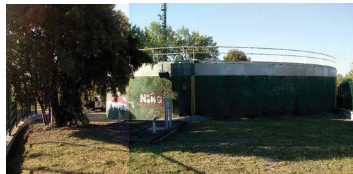
Vista del dipòsit existent.
