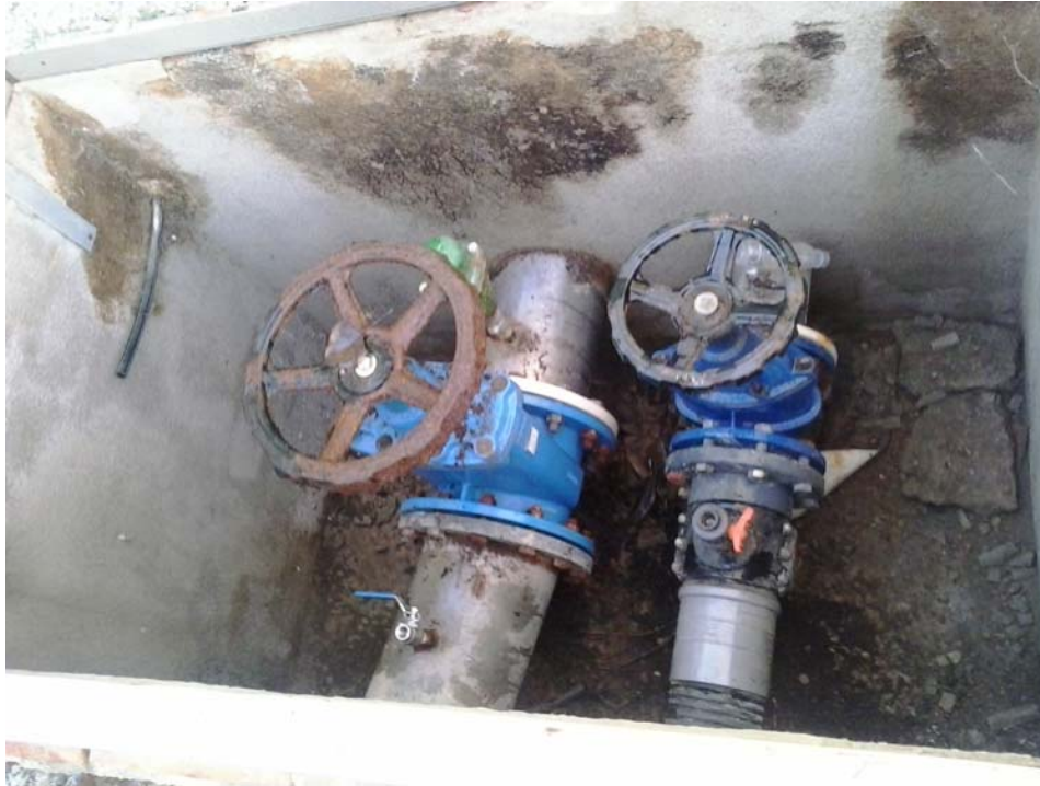
Arqueta A3. Canonada de sortida del dipòsit (esquerra) i canonada de desguàs (dreta)
