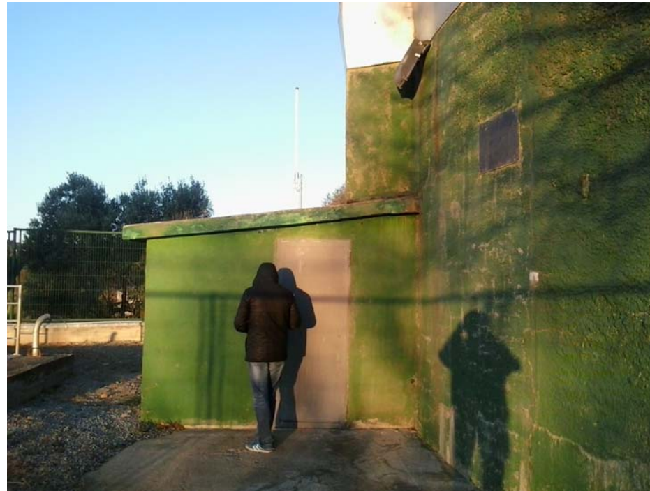
Exterior de la caseta dels equips elèctrics i de control
