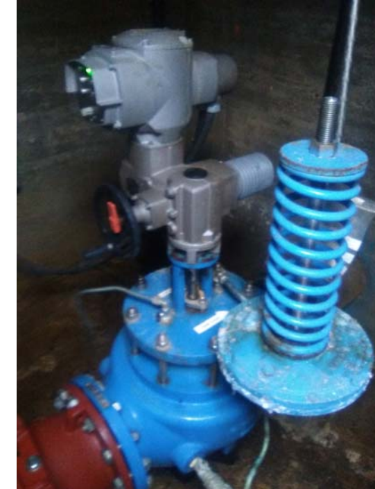
Interior de l'arqueta A1. Vàlvula reguladora a la canonada d'entrada al dipòsit existent
