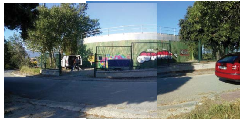
Vista general de la instal·lació, accés.
