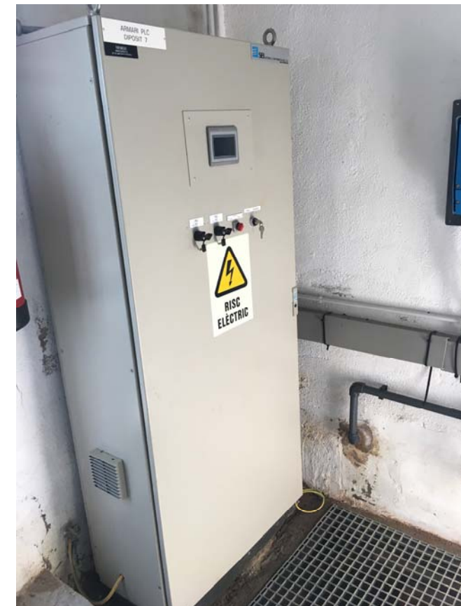
Armari PLC actual
