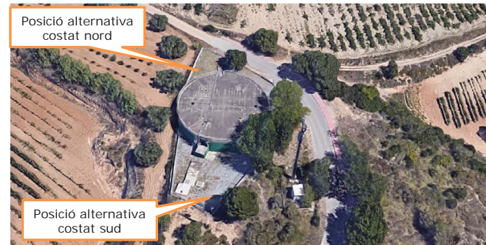
Vista aèria en perspectiva de la instal·lació.
