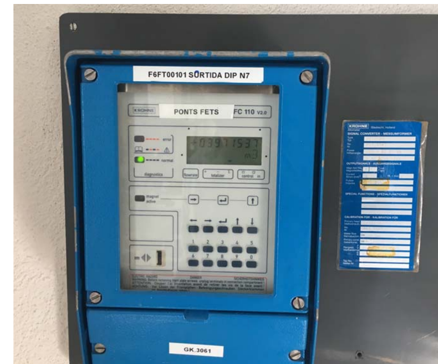
Cabalímetre existent
