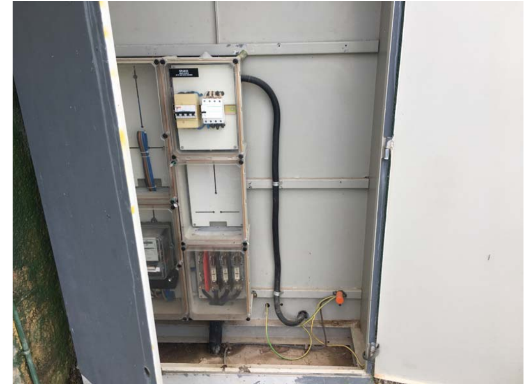
Armari d'escomesa amb Conjunt de Protecció i Mesura existent
