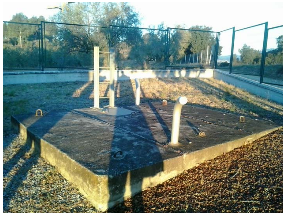
Arqueta A1 d'entrada d'aigua del dipòsit a C-292 i on s'inicia el by-pass
