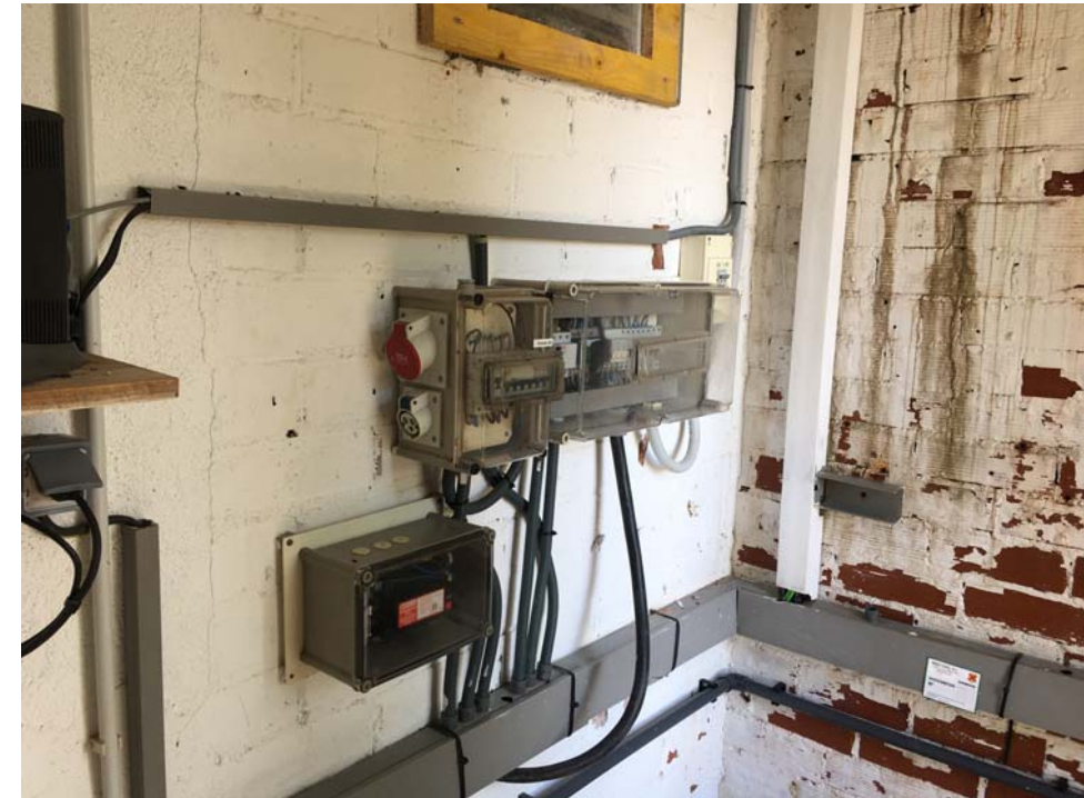
Interior de la caseta dels equips elèctrics i de control, protecció general i sobretensions
