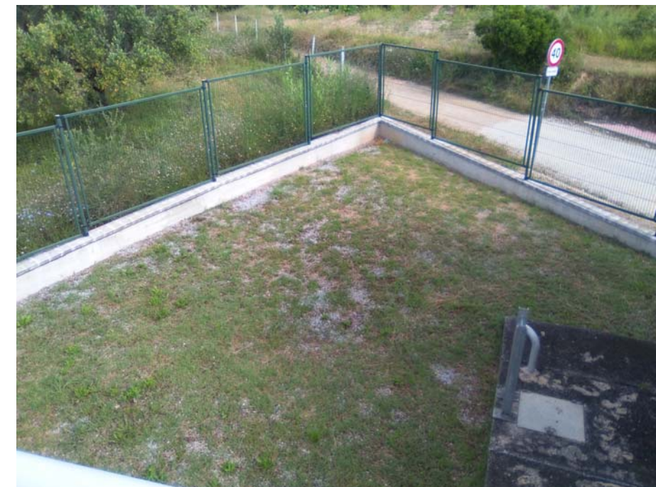
Àrea de la parcel·la on s'ubicarà el nou dipòsit
