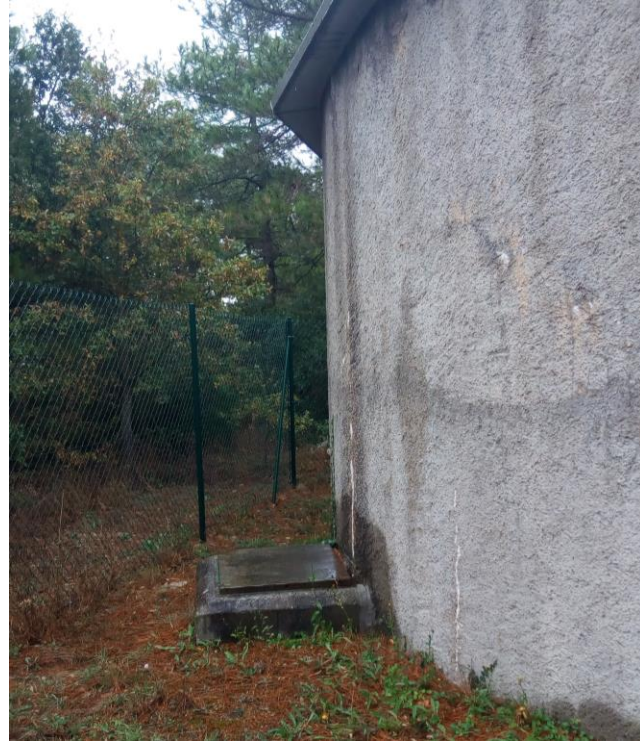
Fotografia 17. Arqueta de buidat del dipòsit vell de l'Espona.
