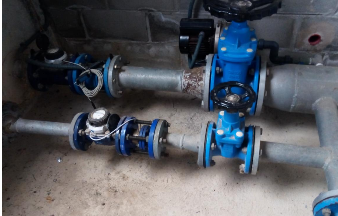
Fotografia 21. Detall del conductes de dins el dipòsit nou de l'Espona.
