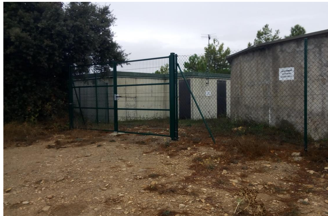
Fotografia 14. Nou dipòsit de l'Espona a l'esquerra i dipòsit vell a la dreta de la fotografia.
