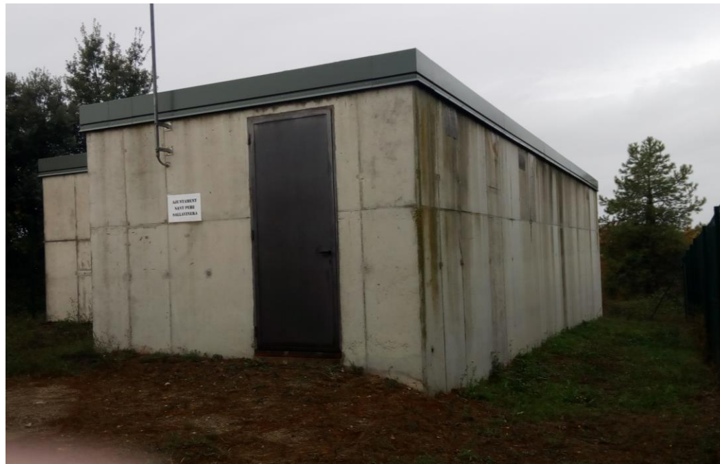
Fotografia 18. Dipòsit nou de l'Espona.
