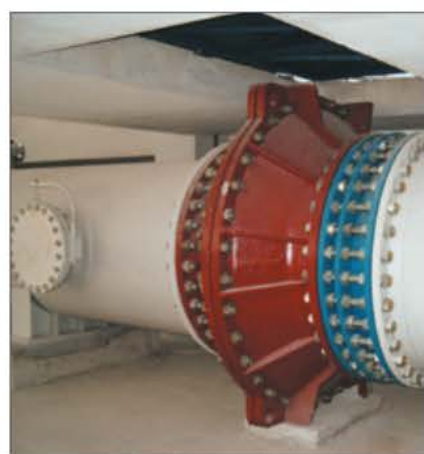
Instalación de la válvula CLASAR® DN1400 (56")
