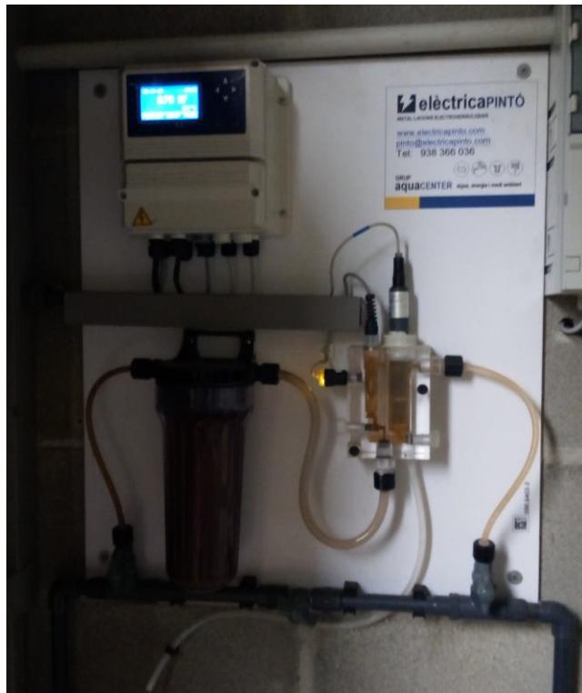
Fotografia 22. Detall del sistema de cloració del dipòsit nou de l'Espona.
