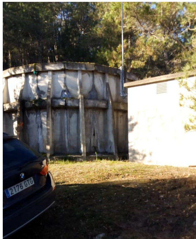
Fotografia 10. Vista exterior d'un dipòsit municipal, al costat del Camí de la Llavina
