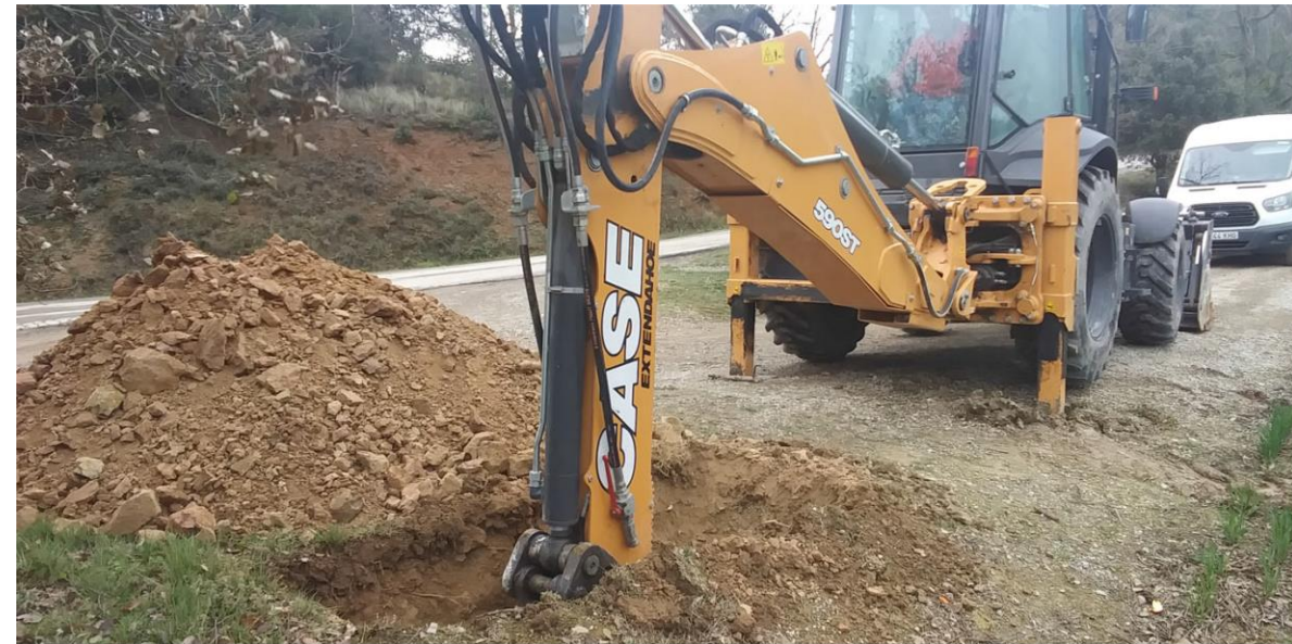
Figura 1. Excavació de la cala CSP-2.
