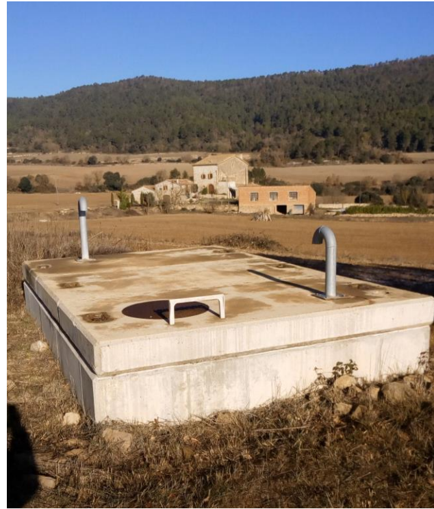
Fotografia 1. Arqueta de seccionament existent de l'arteria del Cardener (conducció Anoia Centre) R6 2+914 S01 CM1, des d'on es derivarà la conducció fins al dipòsit de L'Espona.
