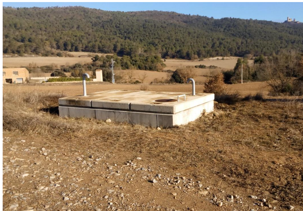
Fotografia 2. Voltants mateixa arqueta de seccionament.
