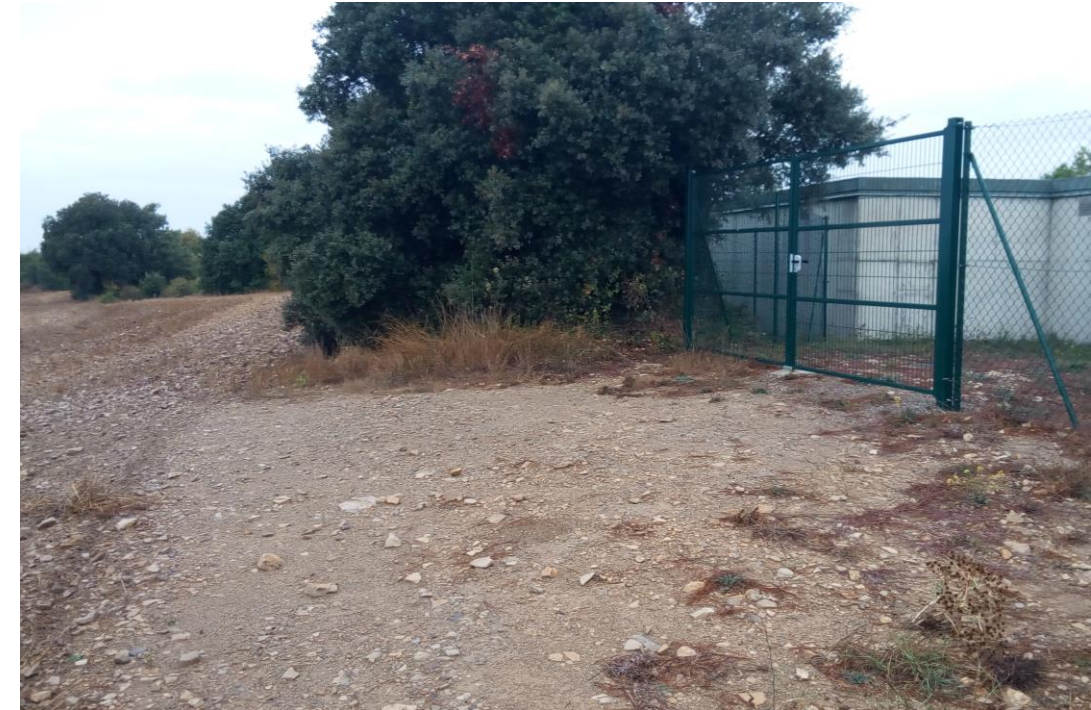
Fotografia 15. Arbrat exterior del dipòsit de l'Espona on hi haurà ubicada l'arqueta final de línia.
