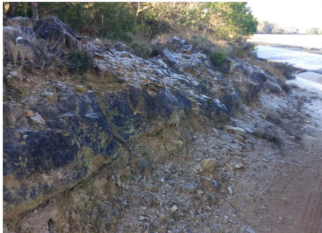
Fotografia 6. Detall marge lateral del camí al costat a l'arqueta de connexió.
