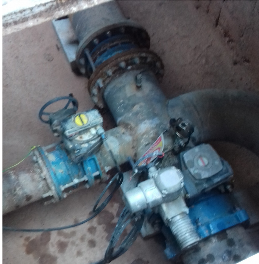
Fotografia 1: Interior de l'arqueta d'arribada. Canonada d'arribada (dalt), entrada al dipòsit auxiliar (dreta), entrada dipòsit actual (baix) i by-pass (esquerre).
