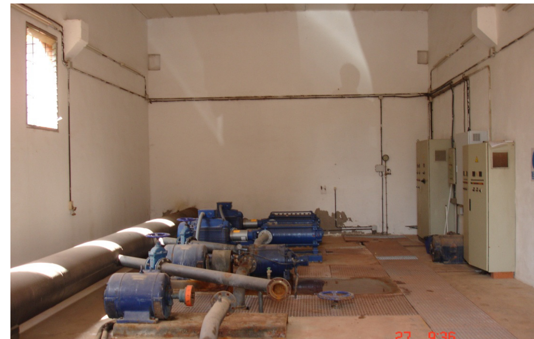
Fotografia 10: Interior de l'estació de bombament.
