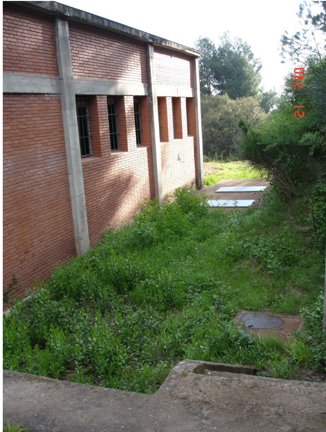
Fotografia 8: Edifici de l'estació de bombament. Al fins s'observen les dues tapes de l'arqueta d'arribada.
