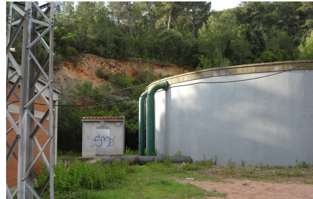
Fotografia 9: Dipòsit actual. S'observen les canonades d'entrada, sortida i sobreeixidor, la caseta de control i els talussos existents.
