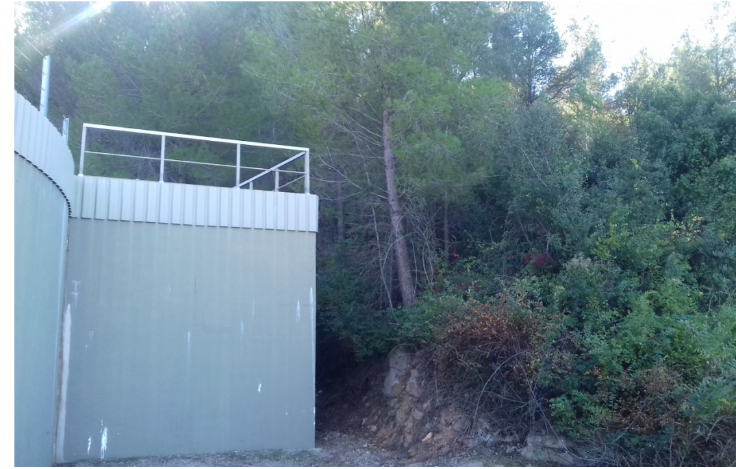
Fotografia 6: A la dreta, ubicació del nou dipòsit. A l'esquerre, dipòsit de trencament de càrrega
