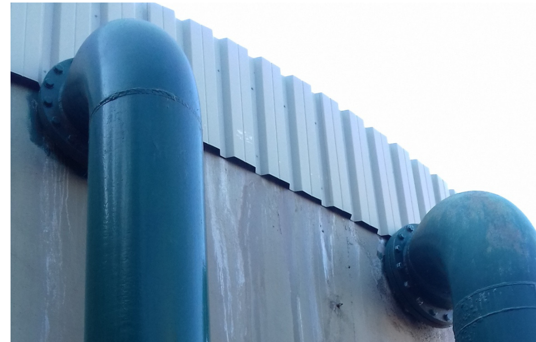
Fotografia 3: Canonades d'entrada (esquerre) i sobreexidor del dipòsit existent (dreta)
