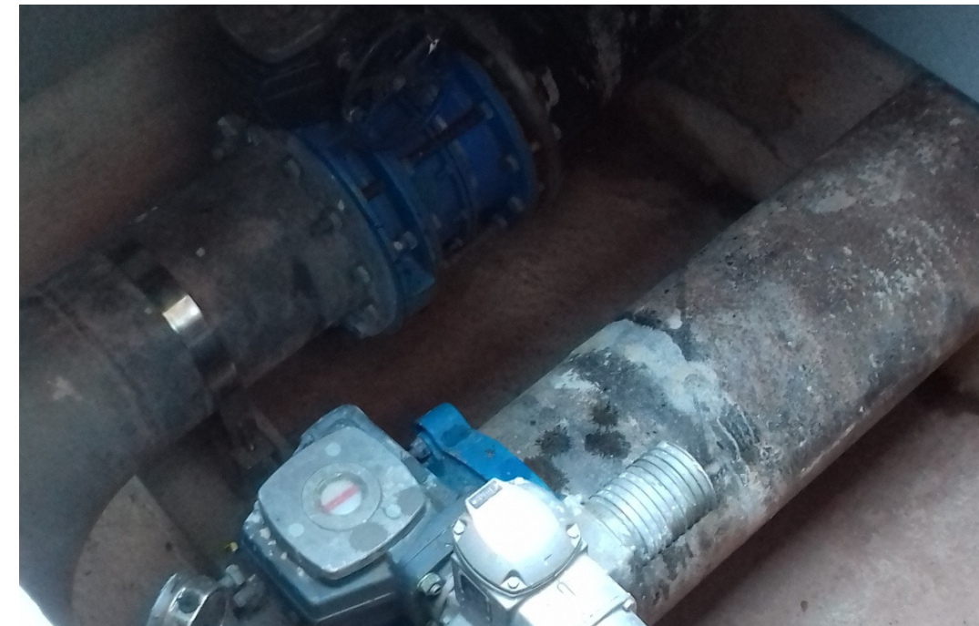
Fotografia 2: Interior de l'arqueta d'arribada. La canonada dreta és d'entrada al dipòsit actual i l'esquerre d'entrada al dipòsit auxiliar.
