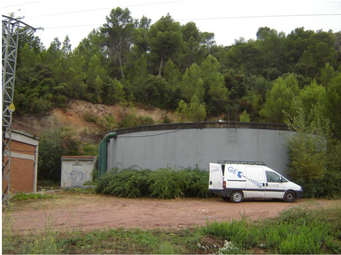
Estació de bombament i dipòsit existent al costat de la zona d'implantació del nou dipòsit.
