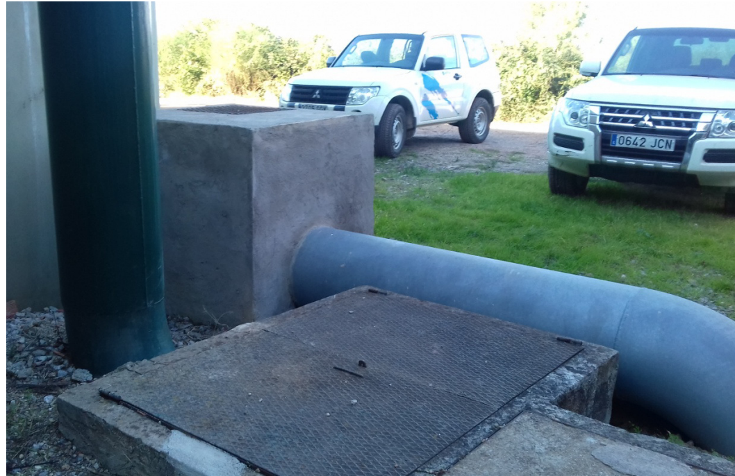
Fotografia 4: Arqueta de desguàs (baix) i arqueta de sortida (dalt).
