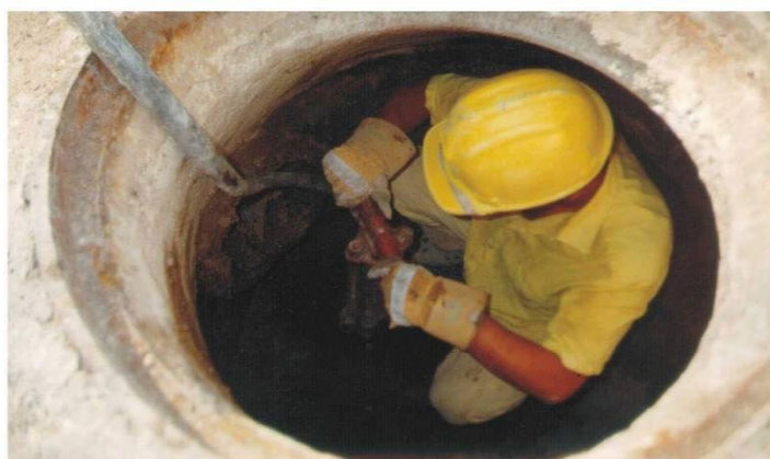
DEMOLICIÓN MANUAL EN INTERIOR DE POZO
