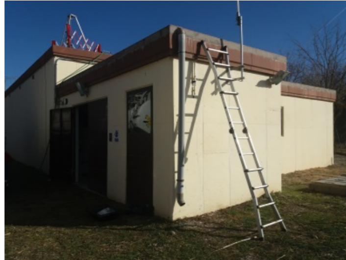
B3-02 DIPÒSIT ASPIRACIÓ E.B. SANT MARTÍ SARROCA
