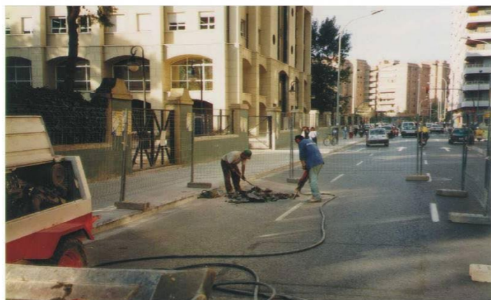
DEMOLICIÓN MANUAL LOCALIZACIÓN DE SERVICIOS
