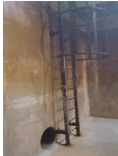
D6-02 DIPÒSIT DE PIERA 2 CAMBRA 2
