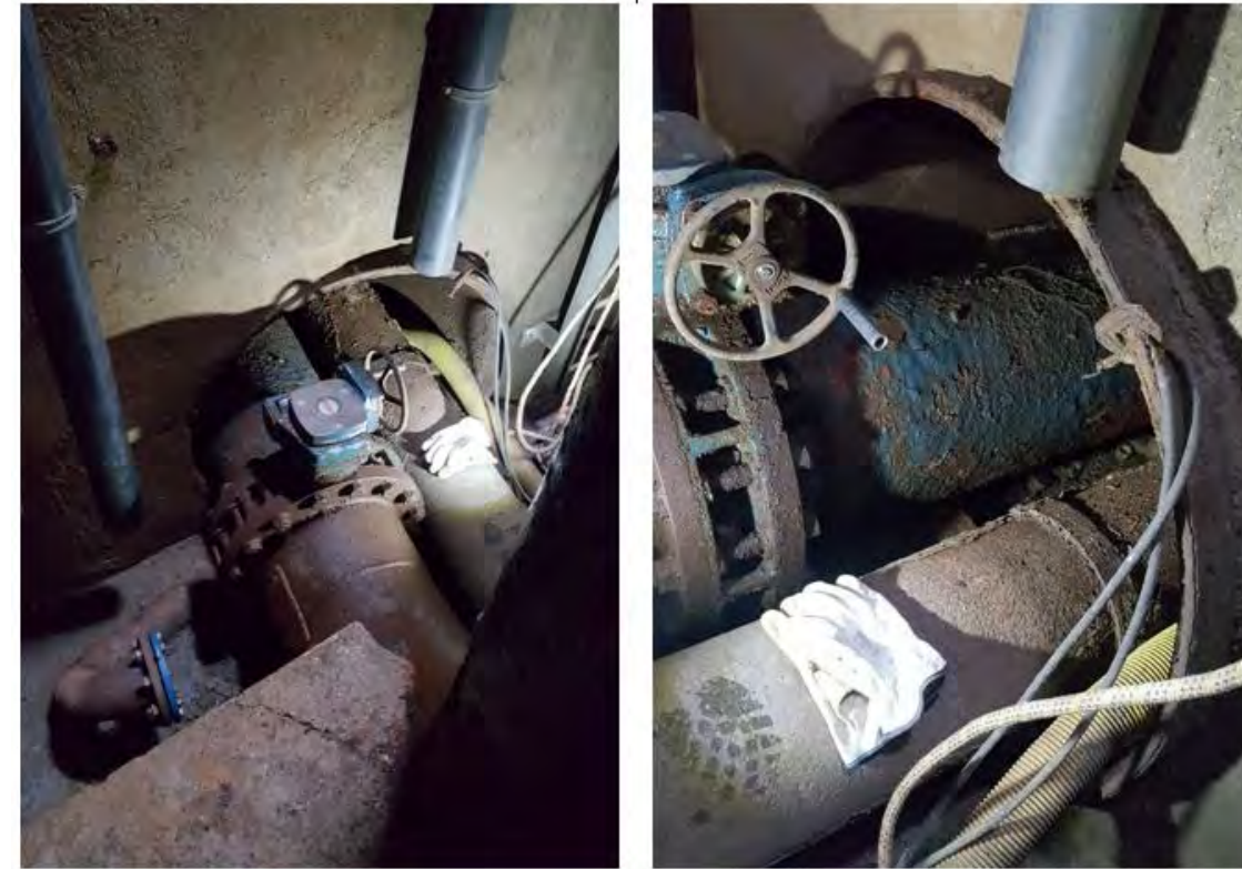
Vàlvules a l'embocadura
