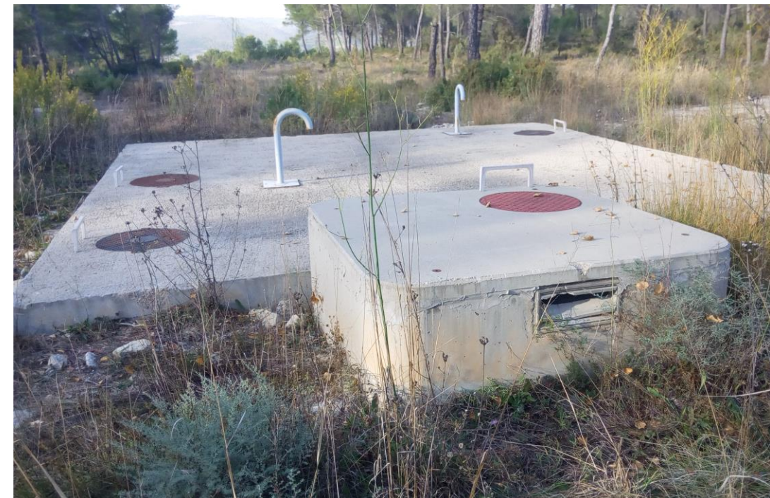
Fotografia 16. En primer pla arqueta de ventosa en pk 25+650 de l'arteria del Cardener, d'on sortirà la conducció de derivació a Jorba.
