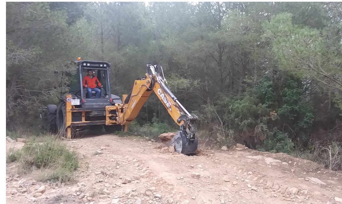
Figura 1. Excavació de la cala CJ-2.
