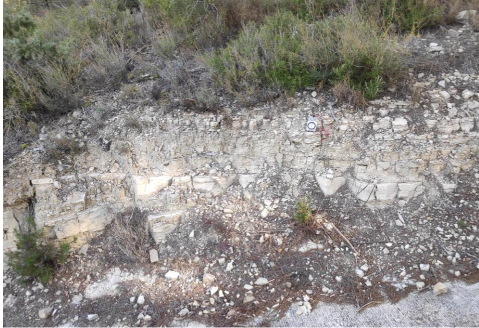
Figura 12. Aspecte de la zona amb margues alterades i gresos grisos.
