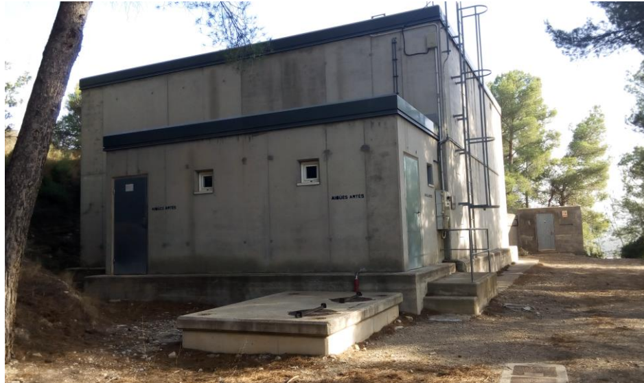
Fotografia 1. Nou dipòsit de 500 m 3 de Jorba. Vista frontal de la seva cambra de claus.
