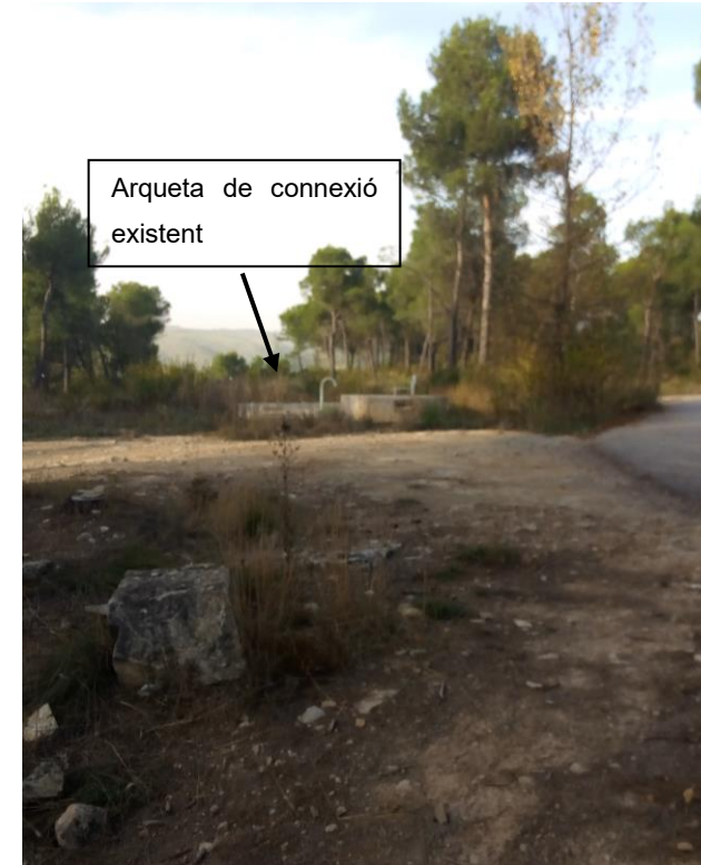
Fotografia 15. Àmbit arqueta de connexió.
