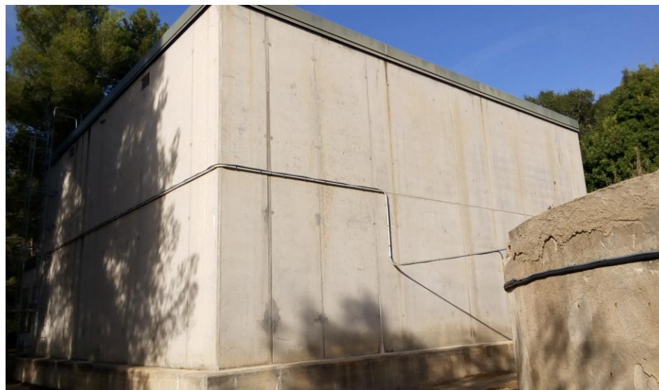
Fotografia 2. Costat esquerre: vista posterior de l'anterior dipòsit (500 m 3 ). Costat dret: antic dipòsit 200 m 3 .
