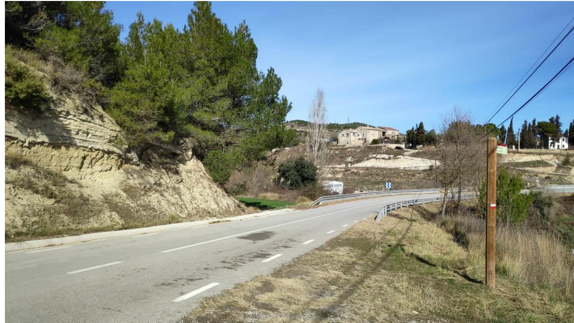
Fotografia 9. Detall de la carretera i l'àmbit per on transcorrerà la canonada.
