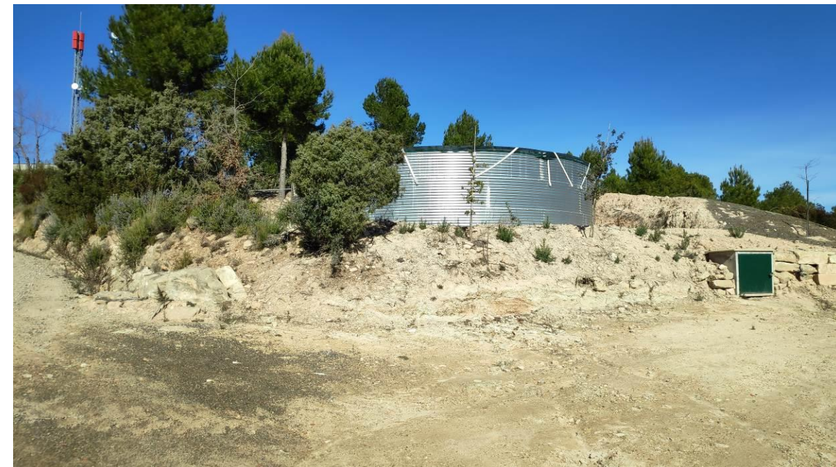
Fotografia 24. Detall d'un primer dipòsit abans del municipal.
