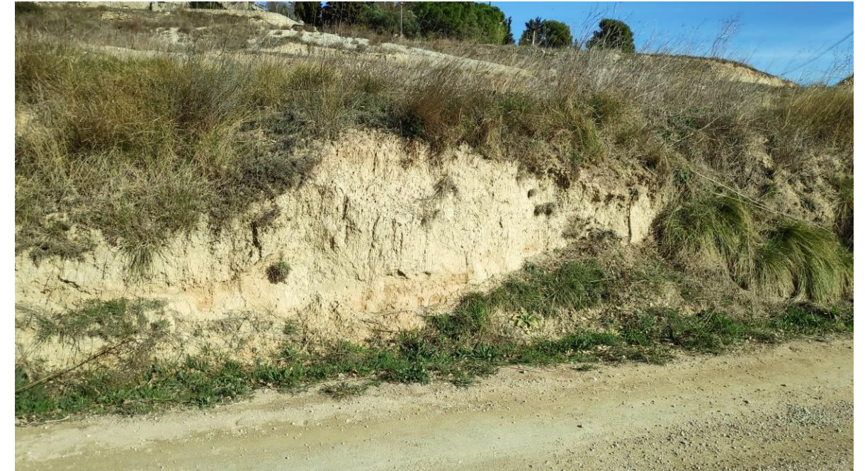
Fotografia 11. Detall del tipus de terreny en el talús del marge dret del camí.
