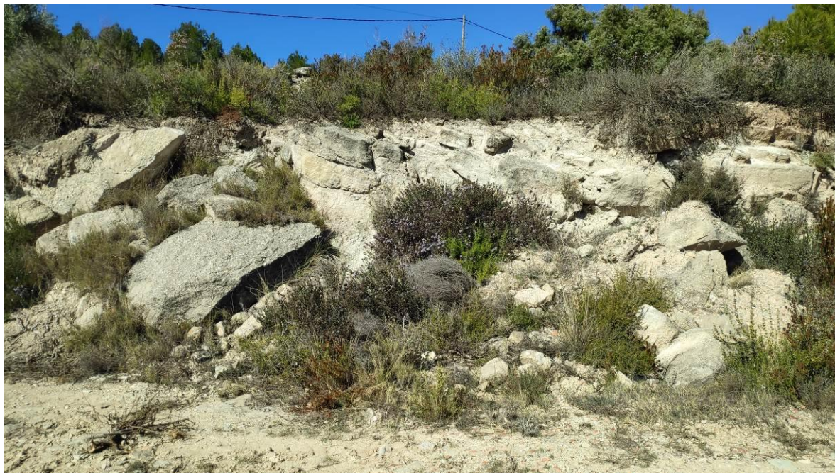
Fotografia 22. Detall marge lateral del camí..
