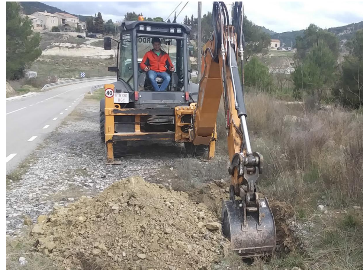
Figura 1. Excavació de la cala CR-1.
