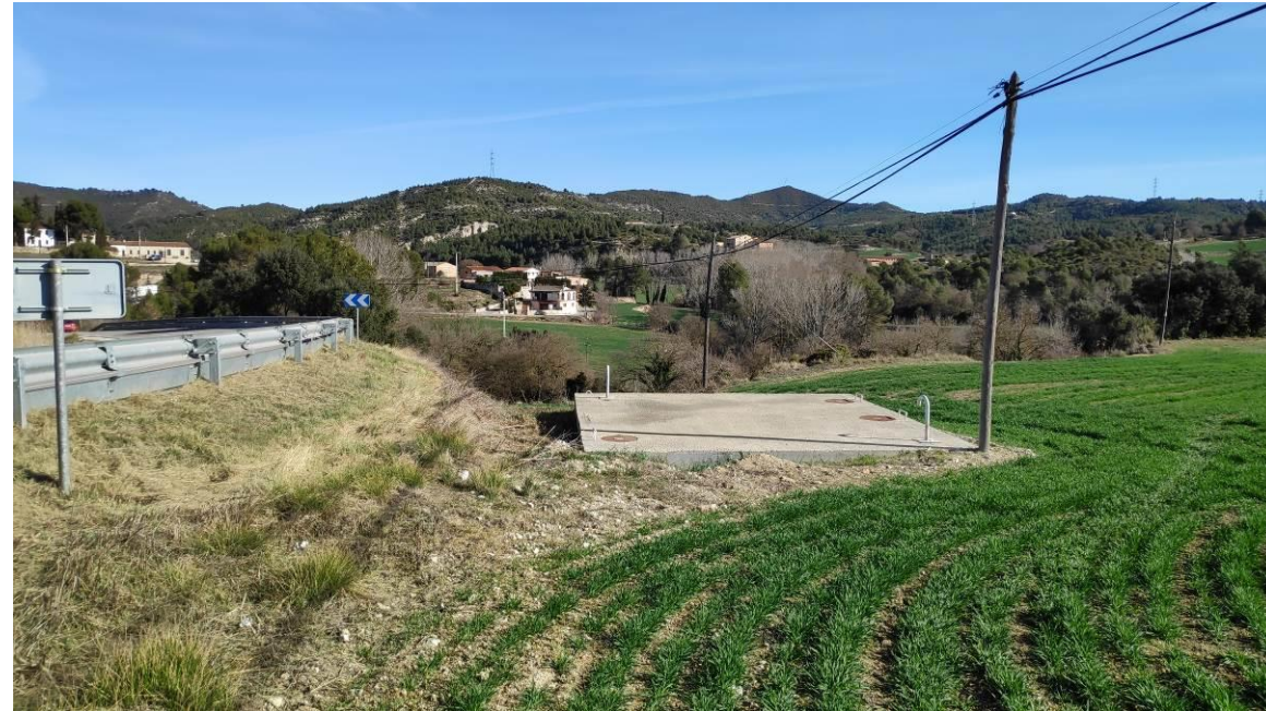
Fotografia 1. Arqueta de l'arteria del Cardener, en pk 23+878, a partir de la qual es derivarà la conducció projectada.
