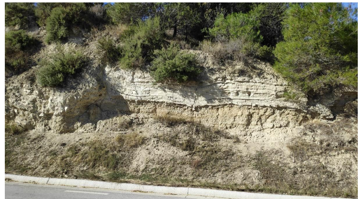
Fotografia 4. Detall talús rocós davant de l'esmentada arqueta.
