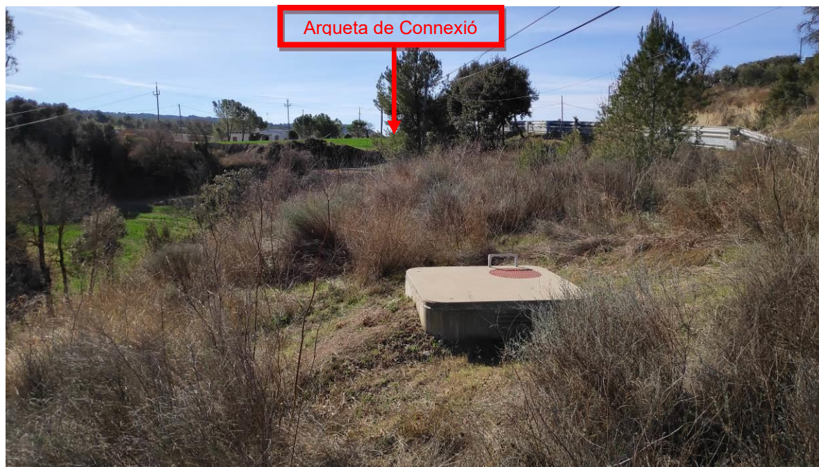
Fotografia 6. Àmbit per on transcorrerà la canonada, al voltant del pk 0+080. Arqueta de l'arteria del Cardener en primer pla. Al fons, l'arqueta de connexió.
