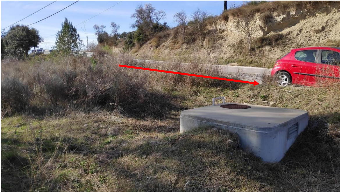
Fotografia 5. Àmbit per on transcorrerà la canonada, al voltant del pk 0+080. Arqueta de l'arteria del Cardener en primer pla
