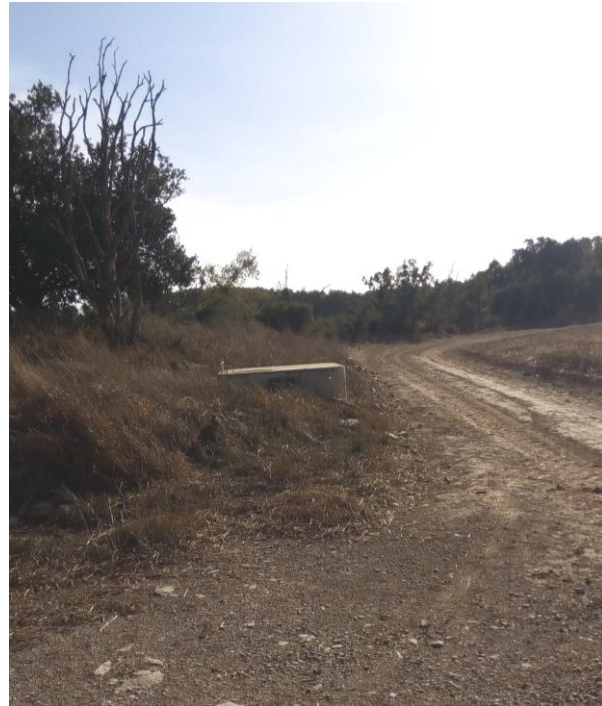
Fotografia 1. Arqueta d'hidrant de la conducció del cardener, des d'on sortirà la derivació cap al dipòsit de la Clau.
