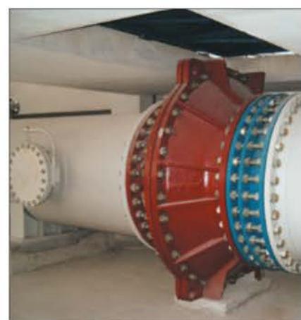
Instalación de la válvula CLASAR® DN1400 (56")
