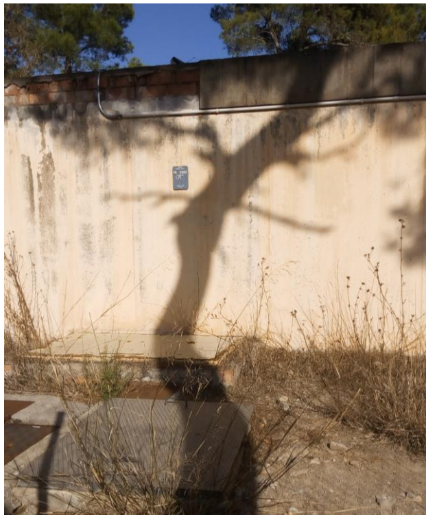
Fotografia 6. Detall arqueta de vàlvules del dipòsit municipal.
