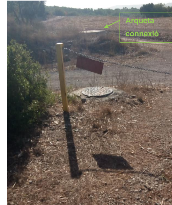
Fotografia 3. En primer pla, hidrant de la xarxa municipal d'abastament. Al fons, arqueta d'ATL.
